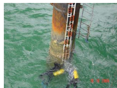
Installation du PVC contenant le capteur contre l'échelle de marée par deux plongeurs
