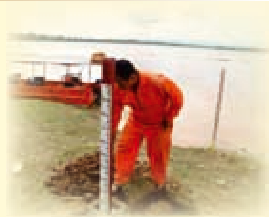
Instalación de reglas limnimétricas en el poblado de Juancito.
