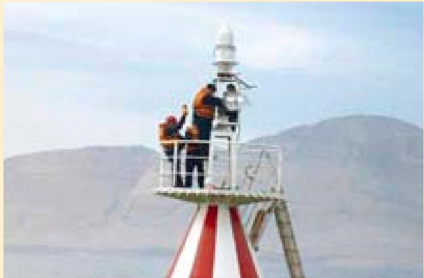
Mantenimiento de boya separadora de tráfico marítimo.
