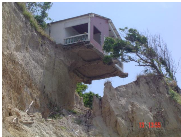
Foto 9.- Vivienda también afectada por la erosión.
