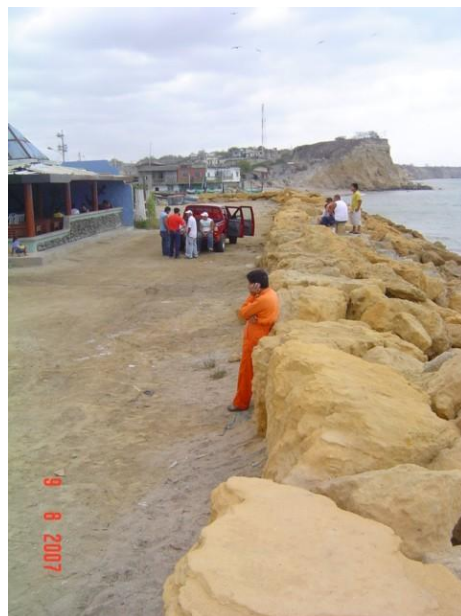
Foto 8.- Muro de contención de grandes rocas en el malecón de Jaramijó.
