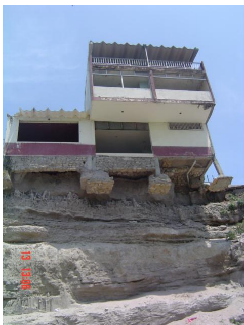
Foto 7.- Vivienda en lo alto del acantilado, en cualquier momento podría caer.
