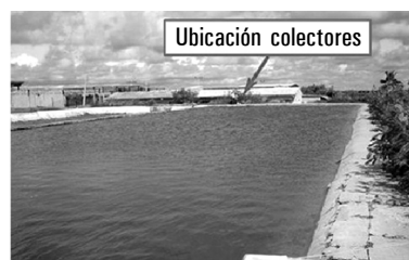
Fig. 1. Piscina de sedimentación de 2 000 m 3 .
