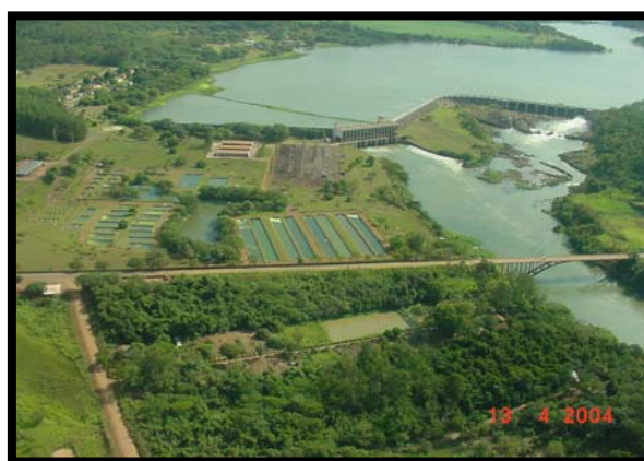
Figura 4. Vista aérea da Estação de Hidrologia e Aquicultura da Duke Energy International , Geração Paranapanema. Fonte: Arquivo Duke Energy International .
