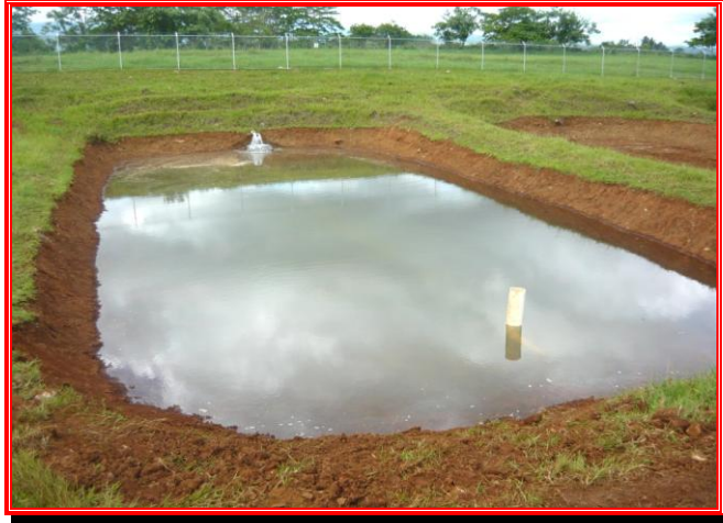
Fig. 16. Estanque construido en tierra de 300 m 2 tipo rústico, se observa la entrada y salida de agua.
