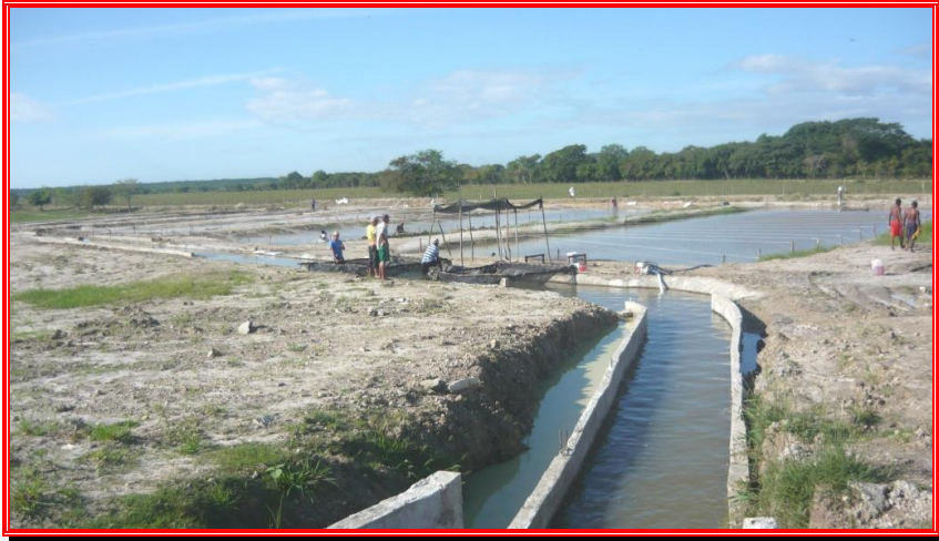
Fig.38. Finca Hacienda Pesa en Coclé, se observa el canal de abastecimiento que permite reposición de agua constantemente para garantizar un recambio de cada estanque en un 50% diario. Sistema intensivo.
