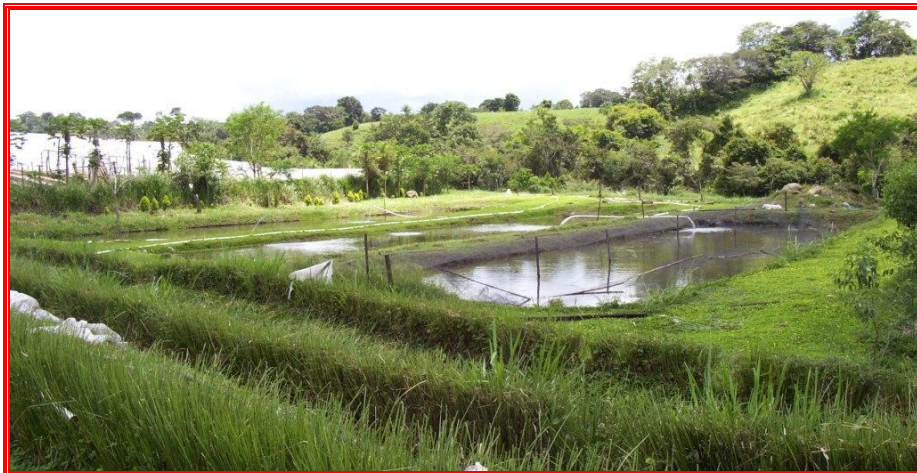
Fig. 8. Batería de estanques de unos 500 m 2 cada uno abastecidos con abundante agua de río por gravedad.
